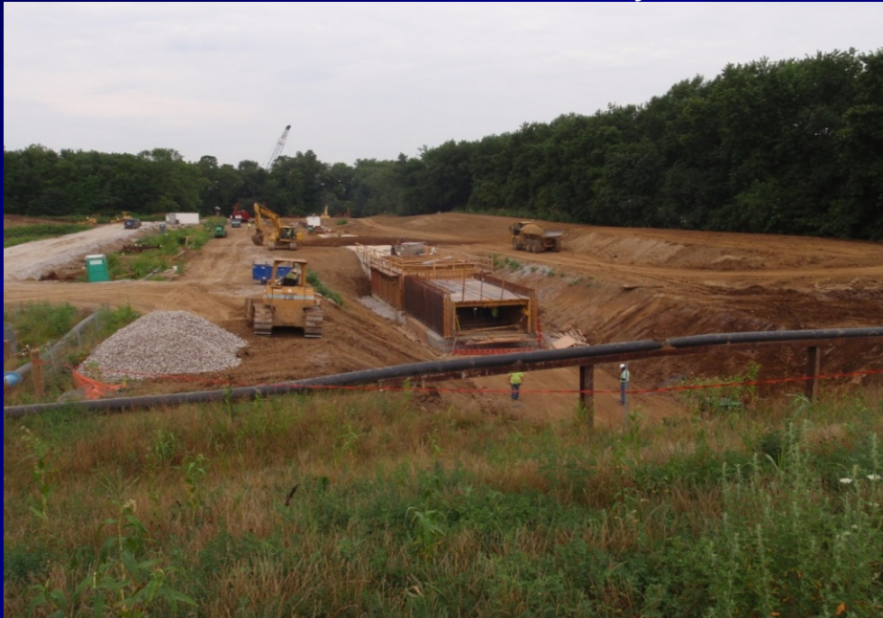
Levee Around Effluent Conduit – May 2010
