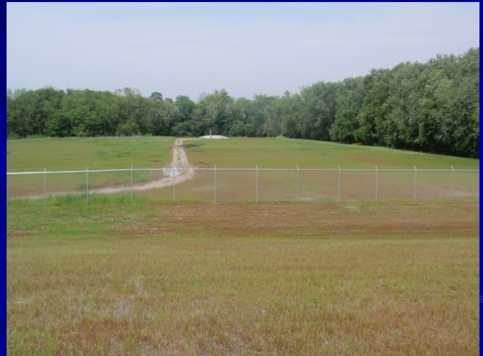
Effluent Conduit Backfilled – May 2010
